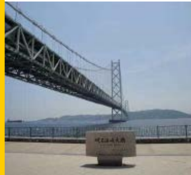
【明石海峡大橋全景】
