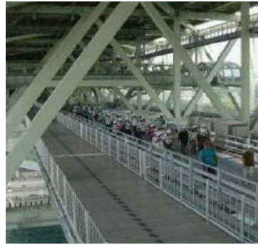
【明石海峡大橋管理路】
