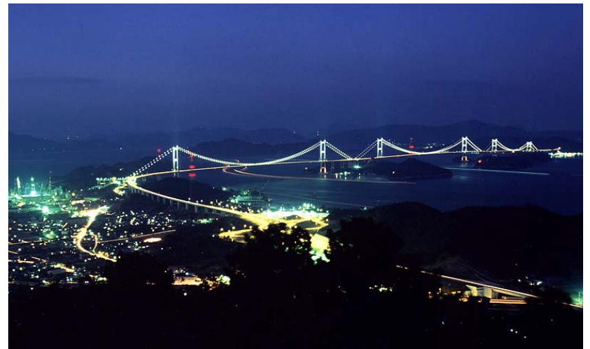
来島海峡大橋
