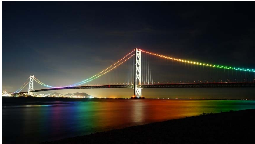
明石海峡大橋
