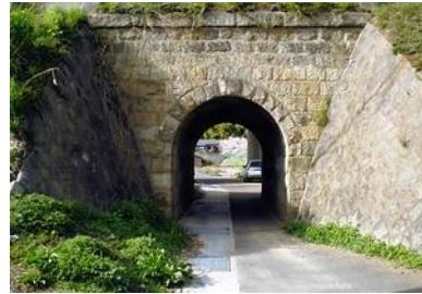
町東部に位置する旧讃岐鉄道の施設。橋長5.9m、単線仕様の小規模な石造単アーチ橋。
